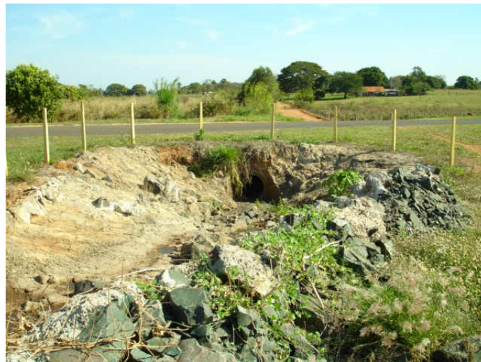
Saída das águas pluviais, em terreno natural, com passagem sob a rodovia, sub-bacia C
